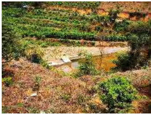
桐木镇那安村水厂水源地现状取水口
