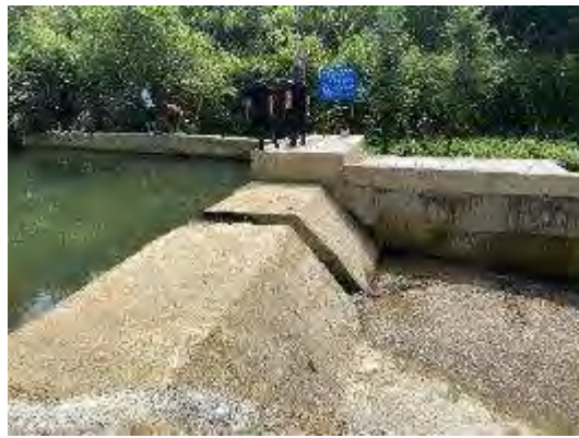
桐木镇那安村搬迁取水口
