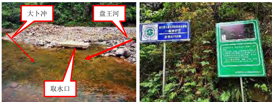
图3.3-1 盘王河水源地现状取水口及现场标识牌相片
