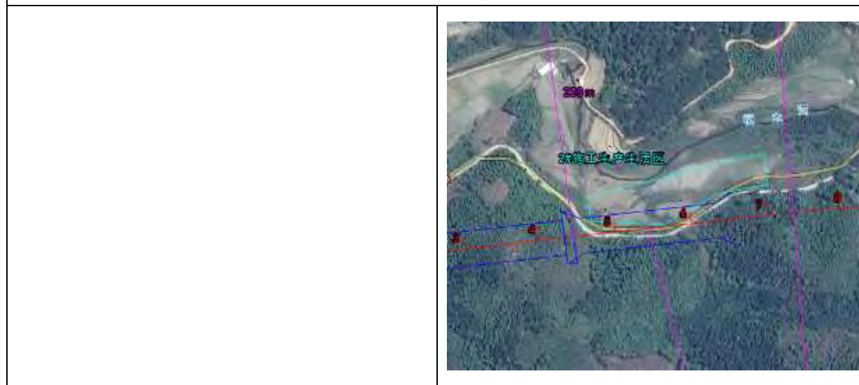
2#施工生产生活区
