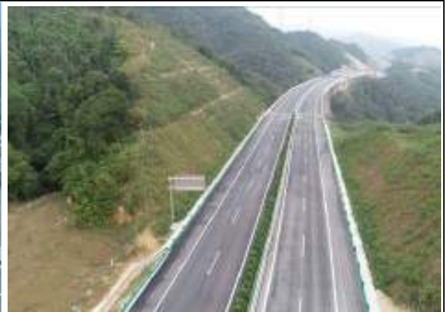
K34+000 路基边坡骨架植草防护
