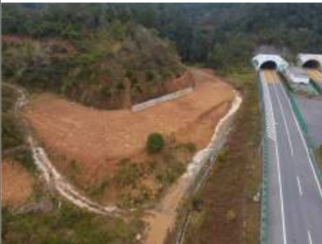
K43+400 隧道拌合站已复耕
