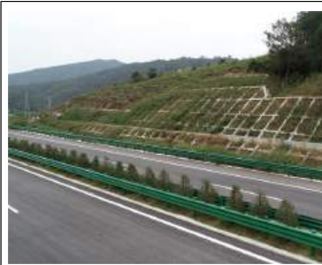
K5+600 路基边坡骨架植草防护
