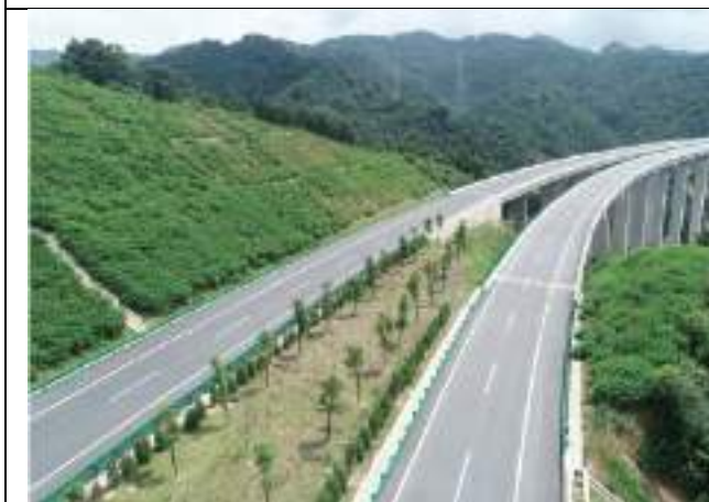
K37+100 路基边坡骨架植草防护
