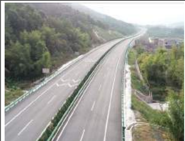
K20+200 路基排水沟
