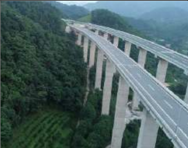
K32+241 白藤 2 号高架大桥
