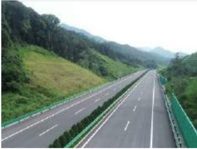
K22+900 路基边坡植草防护
