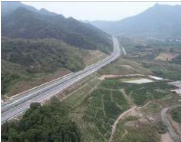
K26+500 路基边坡骨架植草防护
