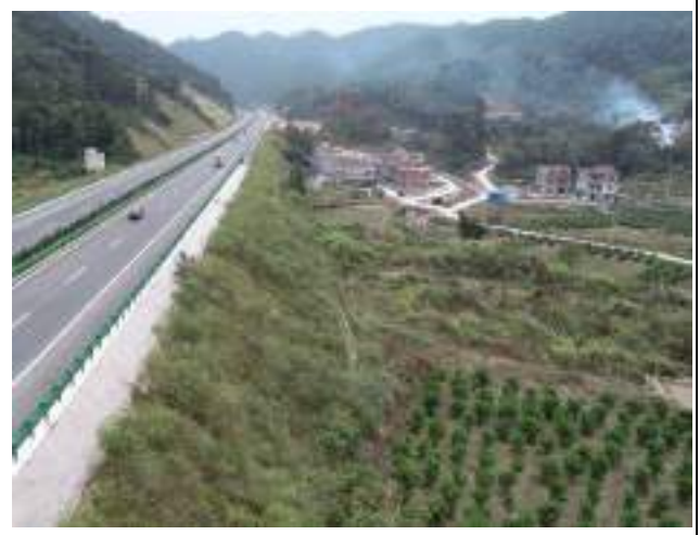
K29+300 路基边坡植草防护
