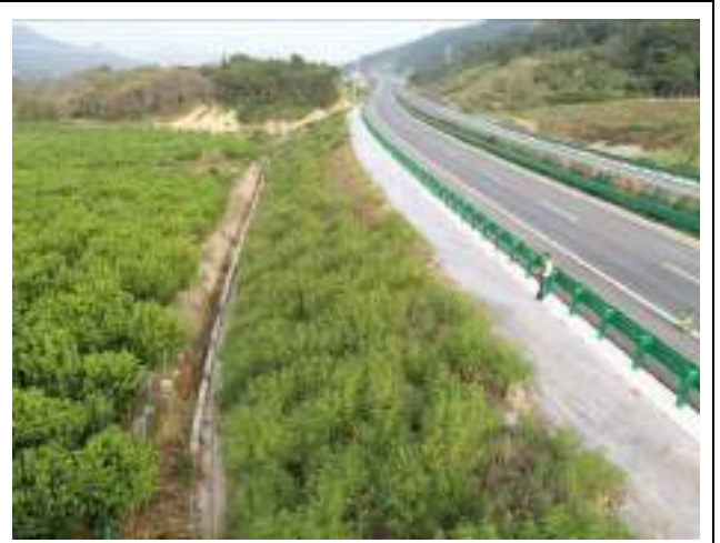
K22+300 路基排水沟和边坡灌草绿化
