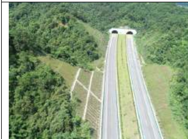
K41+100 路基边坡骨架植草防护
