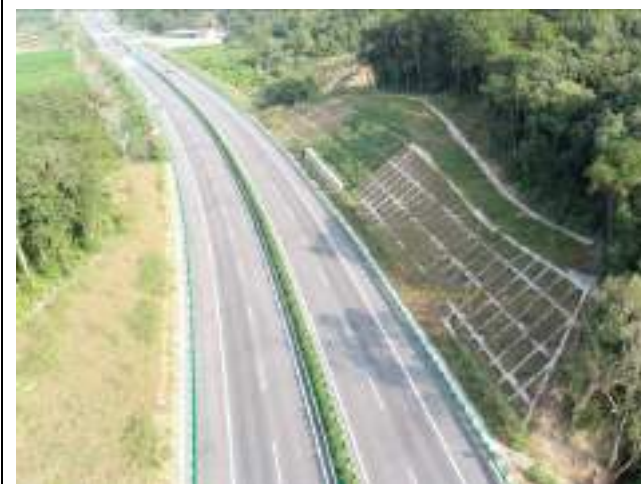
K14+800 路基边坡骨架植草防护
