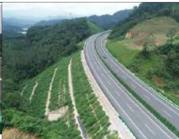
K35+500 路基边坡骨架植草防护
